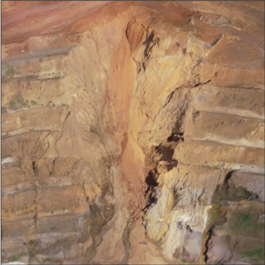
Figura 5-19 – Ruptura do Talude Sul – Vista Frontal (Fonte: Propeller)
